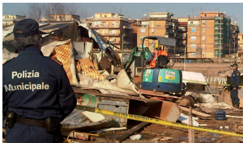
Ruspe al lavoro a Casilino 900 (foto da www.comune.roma.it )
